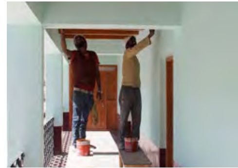
Peinture des couloirs intérieurs
