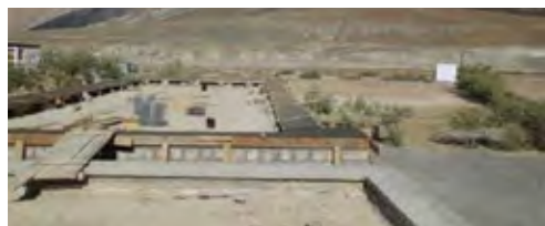
Acrotère pratiquement terminé sur un bâtiment
