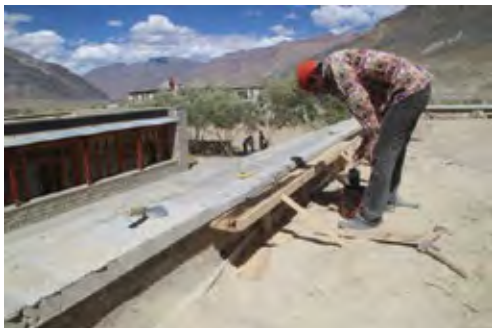
Modification de l'acrotère avec mise en place de la goutte d'eau
