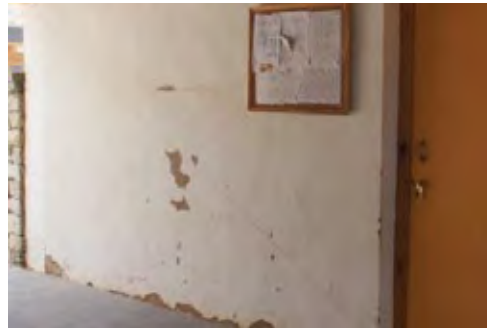
Corridor du NBP
